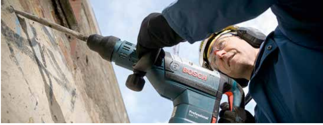
Stemmarbeiten mit dem Schlaghammer GSH 7 VC Professional.
