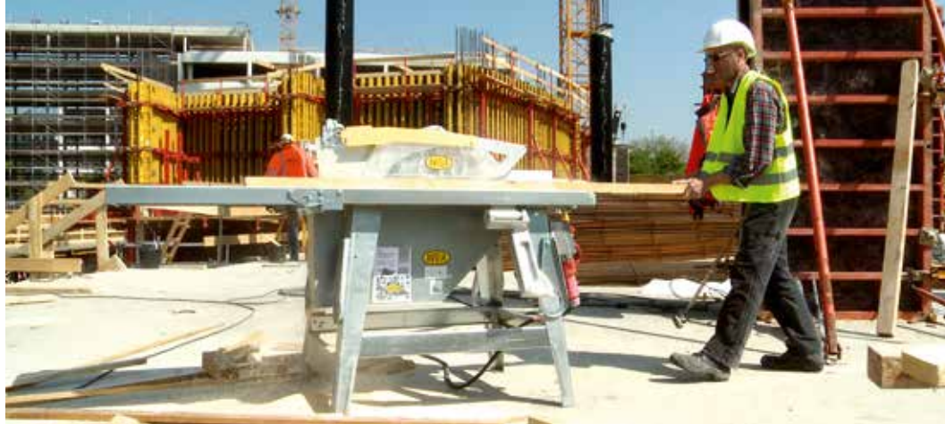
Baukreissäge im Einsatz auf der Baustelle
